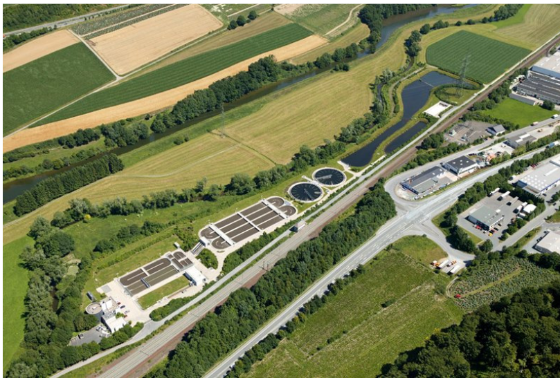
Kläranlage des Ruhrverbandes in Velmede
