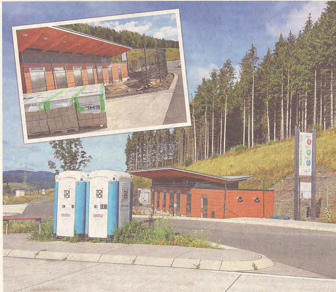
Noch stehen hier am Rastplatz Sengenber Dixi-Klos als provisorische Toilettenanlagen. Das neue WC-Gebäude wird im Herbst in Betrieb genommen. Das Umfeld muss noch gestaltet werden.
