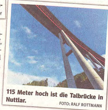
Die Stützweiten der sechs Pfeiler von bis zu 115 Metern sind im Zusammenhang mit der Bauweise nicht alltäglich. FOTO: HANS BLOSSEY
