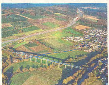
Ein Blick auf die Anschlussstelle Velmede und die A46, die am Montag eröffnet wird. FOTO: HANS BLOSSY
