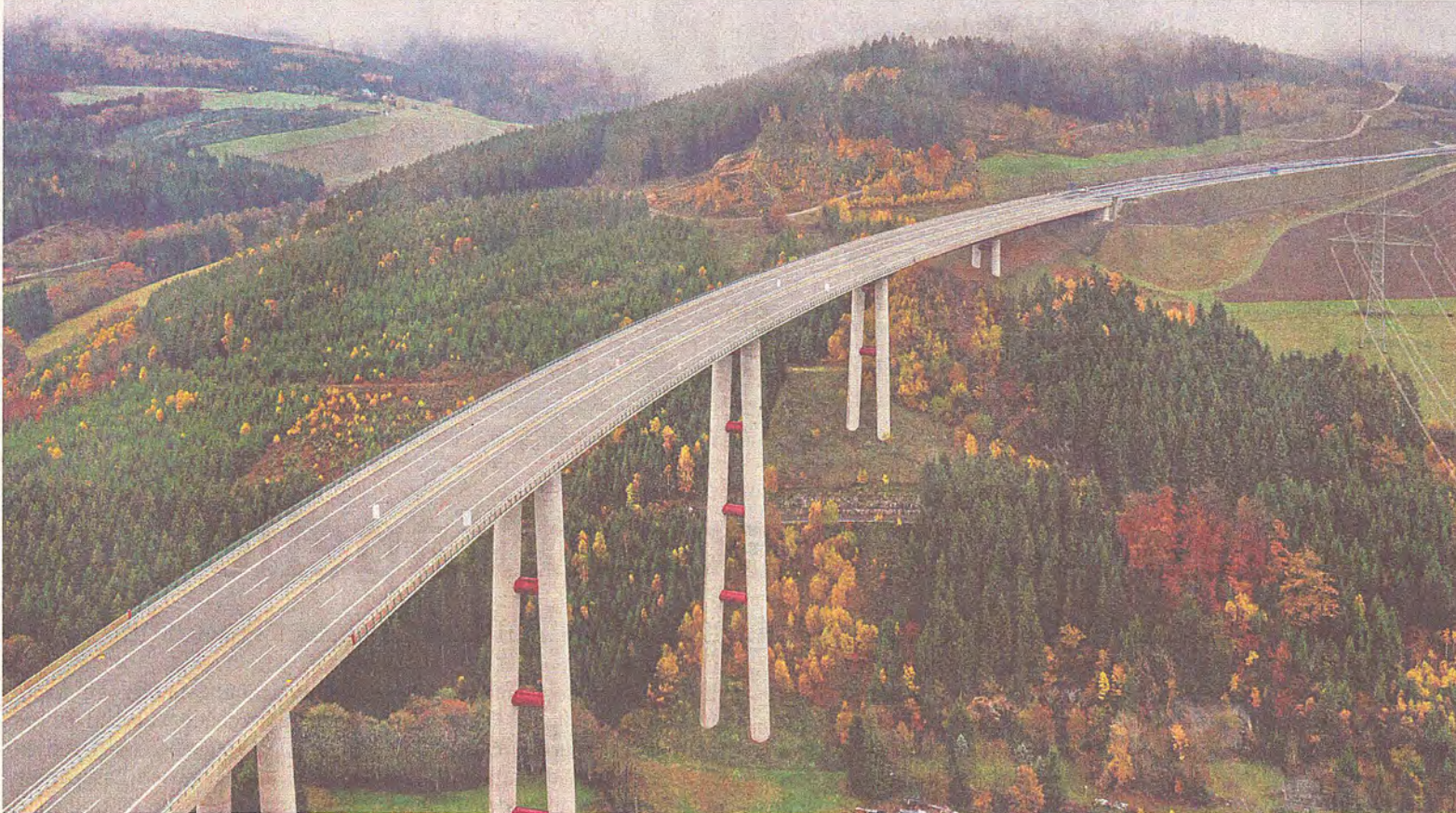
Die Talbrücke Nuttlar: Der Landesbetrieb hat nach 16 Suiziden entschieden, dass das gigantische Bauwerk auf der kompletten Länge einen Zaun bekommen wird - und nicht nur in den Bereichen, die über Straßen und Wege führen. Das gleiche gilt für die Talbrücke Bermecke. FOTO: ANDREAS BUCK
