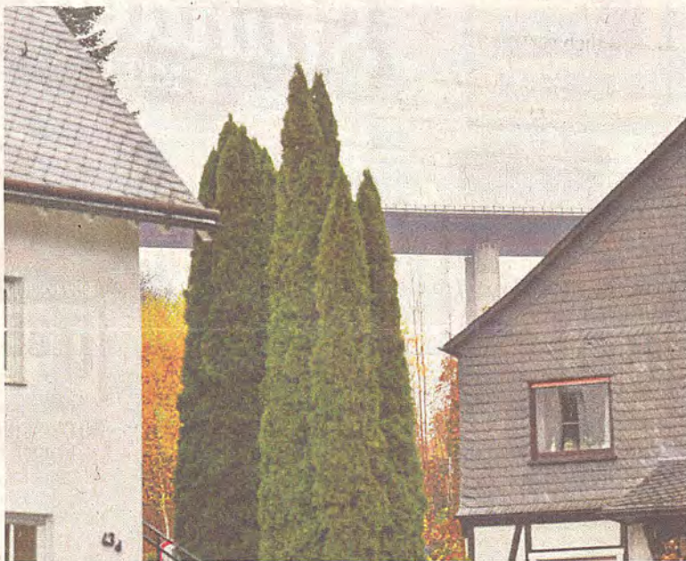
Ganz nah dran am Dorf: Viele Nuttlarer haben inzwischen Angst, die Wege unter der Talbrücke zu nutzen. FOTO: ANDREAS BUCK
