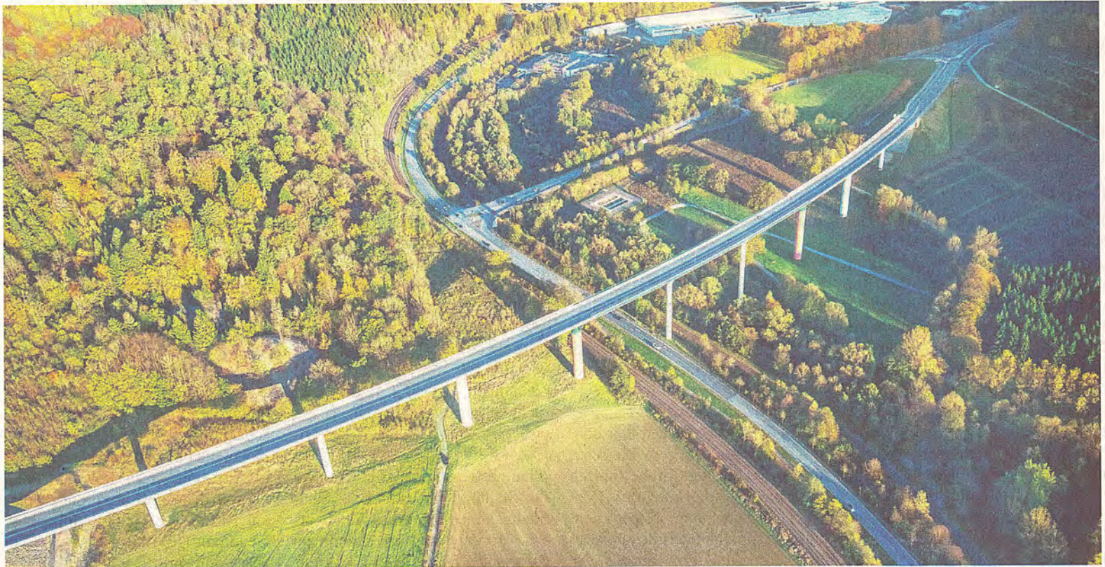
Der Zubringer zur A46 aus der Luft. Die lange Steigungsstrecke wird laut Landesbetrieb vorrangig gestreut.
