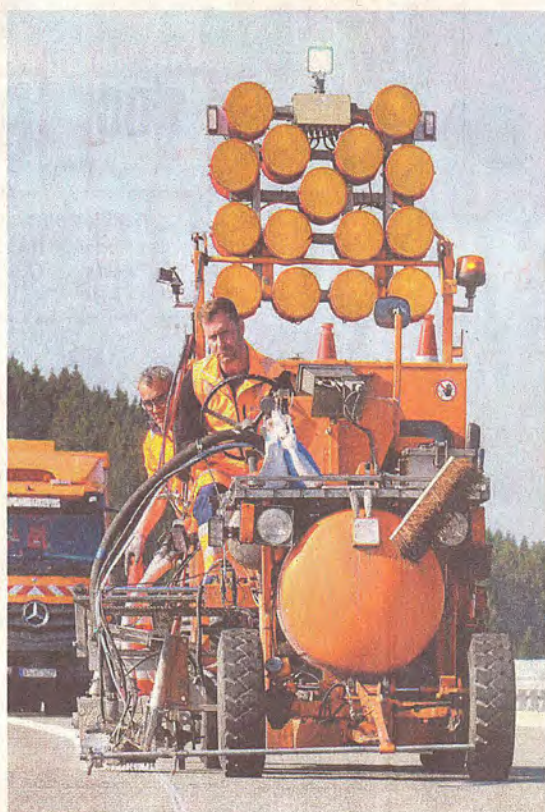
Applikateur Kevin Kleiner bringt die Markierung auf der Talbrücke Nuttlar auf. Sie ist nicht komplett deckend, weil sich damit das Wasser seinen Weg sucht und nicht auf der Markierung stehen bleibt.
