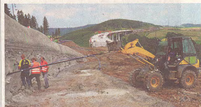
Ein Bild aus der Baustellenzeit: Hier wird der Hang am Sengenbergl aufwendig gesichert, damit er nicht abrutschen kann.
